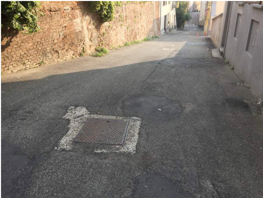
Tratto 1 (via XX Settembre)
