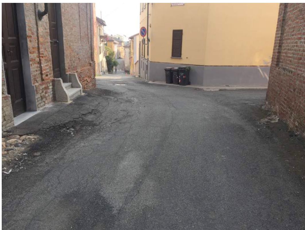
Tratto 1 (via XX Settembre)
