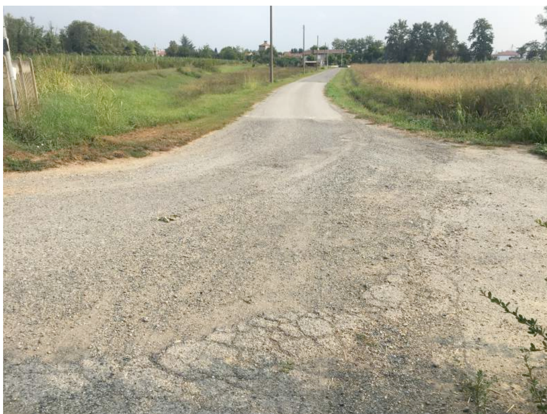
Tratto 3 (via Carentino)
