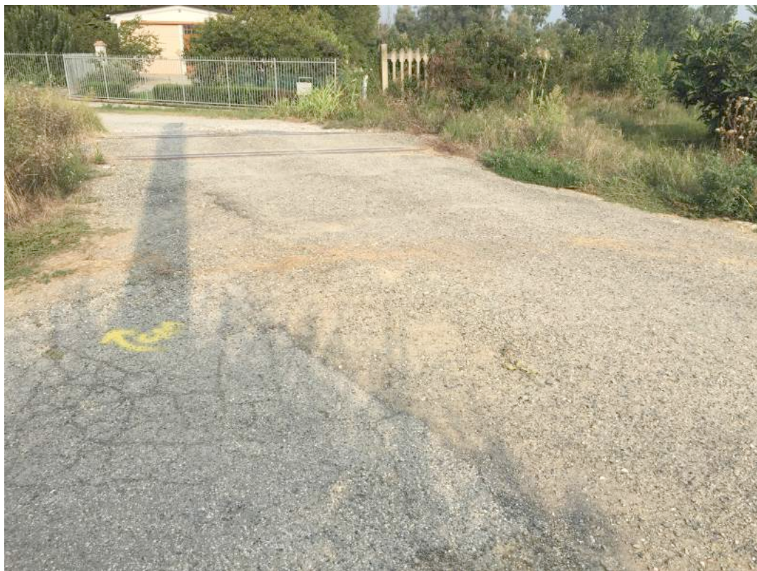
Tratto 3 (via Carentino in corrispondenza del P.L.)
