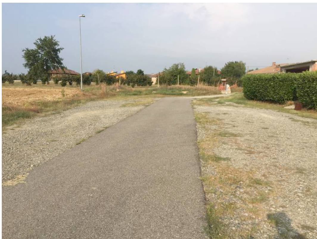
Tratto 2 (tratto finale strada esistente)
