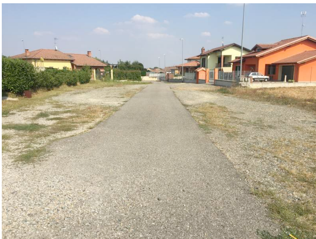
Tratto 2 (tratto di strada esistente PEC)
