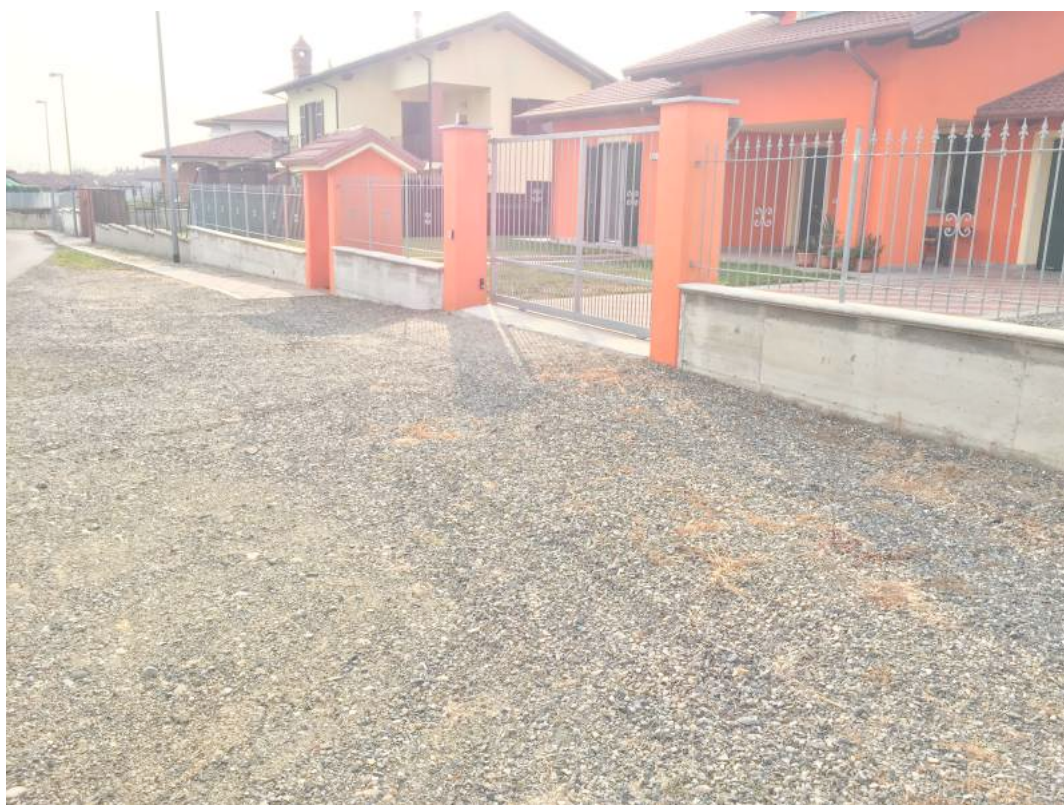
Tratto 2 (tratto futuro marciapiede)
