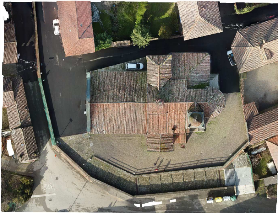
ORTOFOTO RIPRESA CON DRONE
