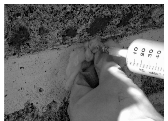
CONSOLIDAMENTO CON INIEZIONI DI MISCELE LEGANTI
