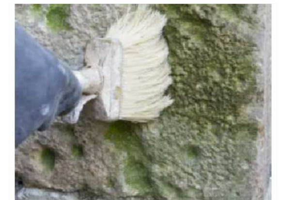
APPLICAZIONE A PENNELLO DI PRODOTTO BIOCIDA
