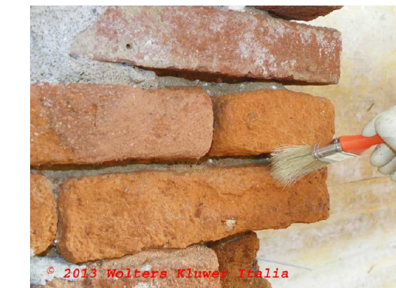
ASPORTAZIONE A SECCO DEI DEPOSITI SUPERFICIALI
