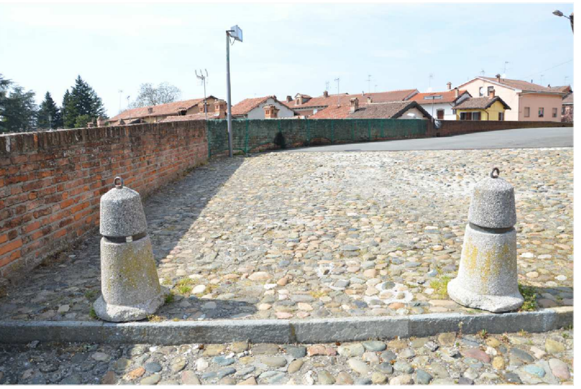
PAVIMENTAZIONE IN CIOTTOLI DI FIUME SCALINATA
