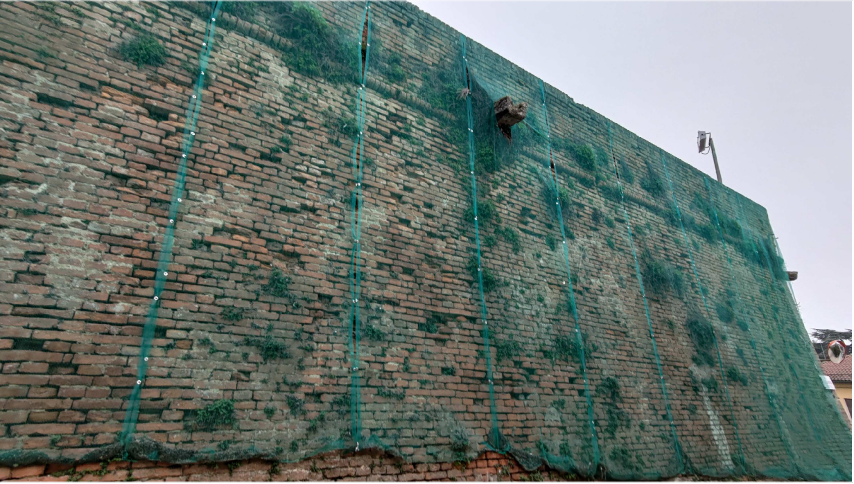
PARTICOLARE DEL PROSPETTO SU VIA ALESSANDRO VOLTA TRATTO MURARIO B-C COPERTO DA TELO VERDE ANTICADUTA
