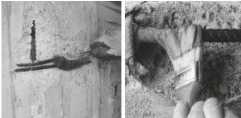
Fig.1_ Trattamento ferri armatura
