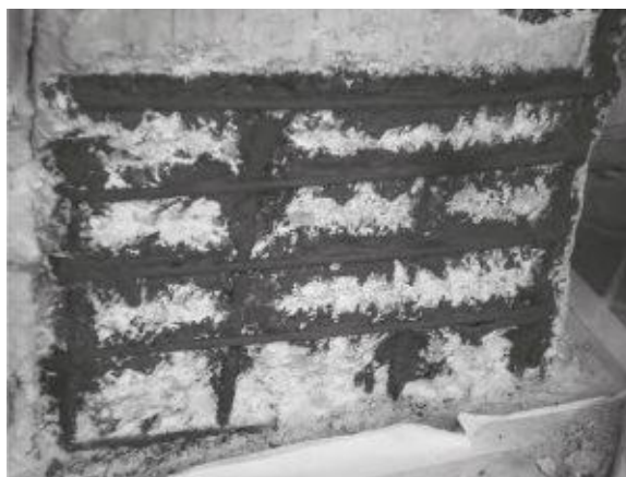
Fig.1_Prima rinzaffatura delle armature
